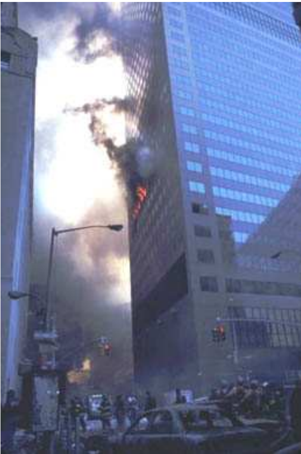
Fig. 2. Incendie au 6 e étage
